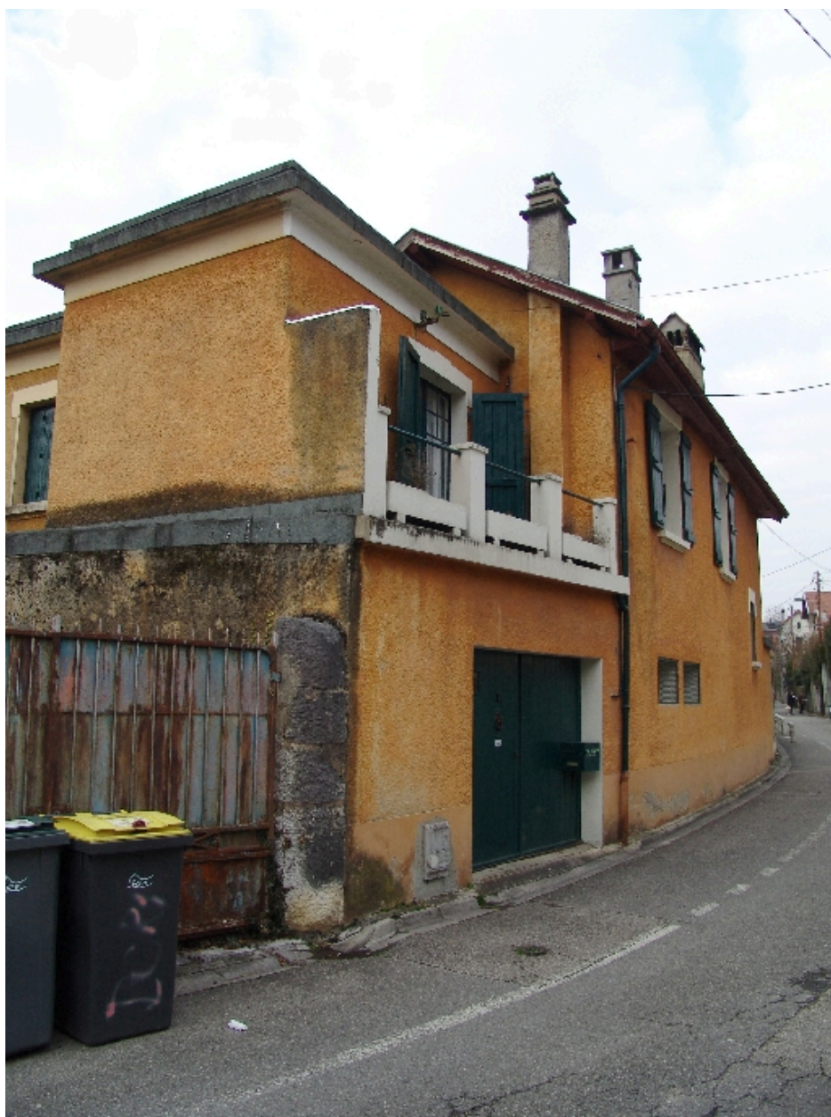
Vue générale prise du sud
