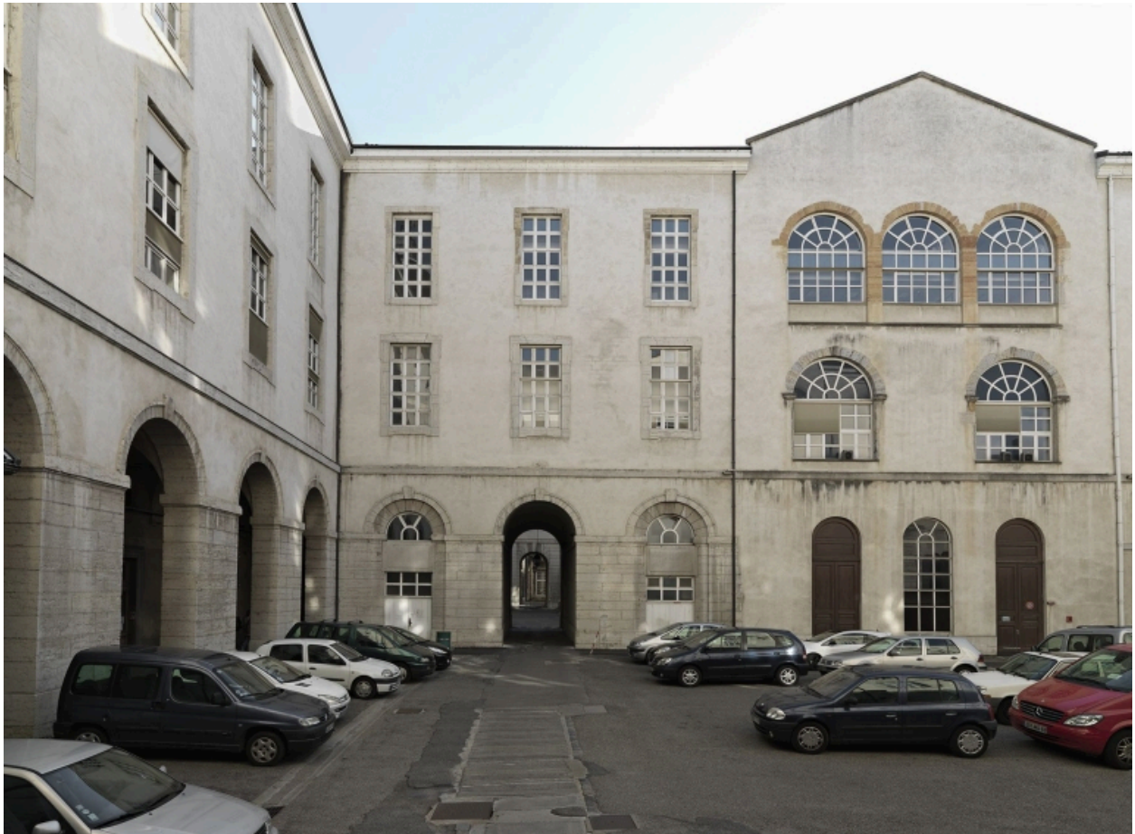
Bâtiment E. Angle nord des bâtiments B et E
