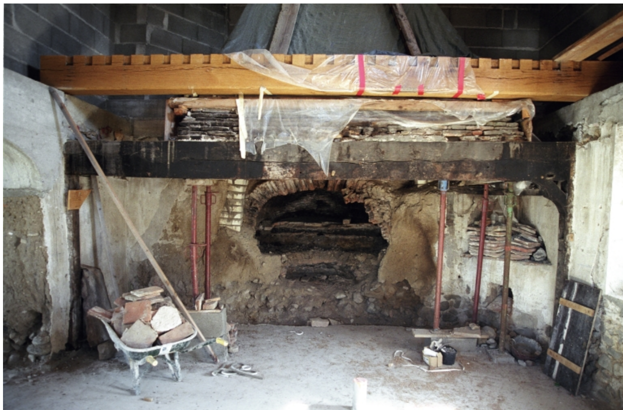
Vue intérieure de la cuisine (2003).
