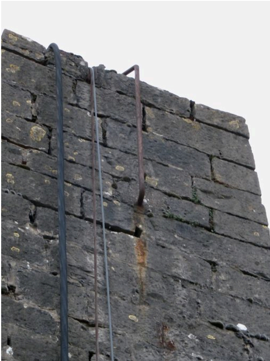
Pile droite, angle nord-ouest, vue de détail : sommet (depuis la rive droite)
