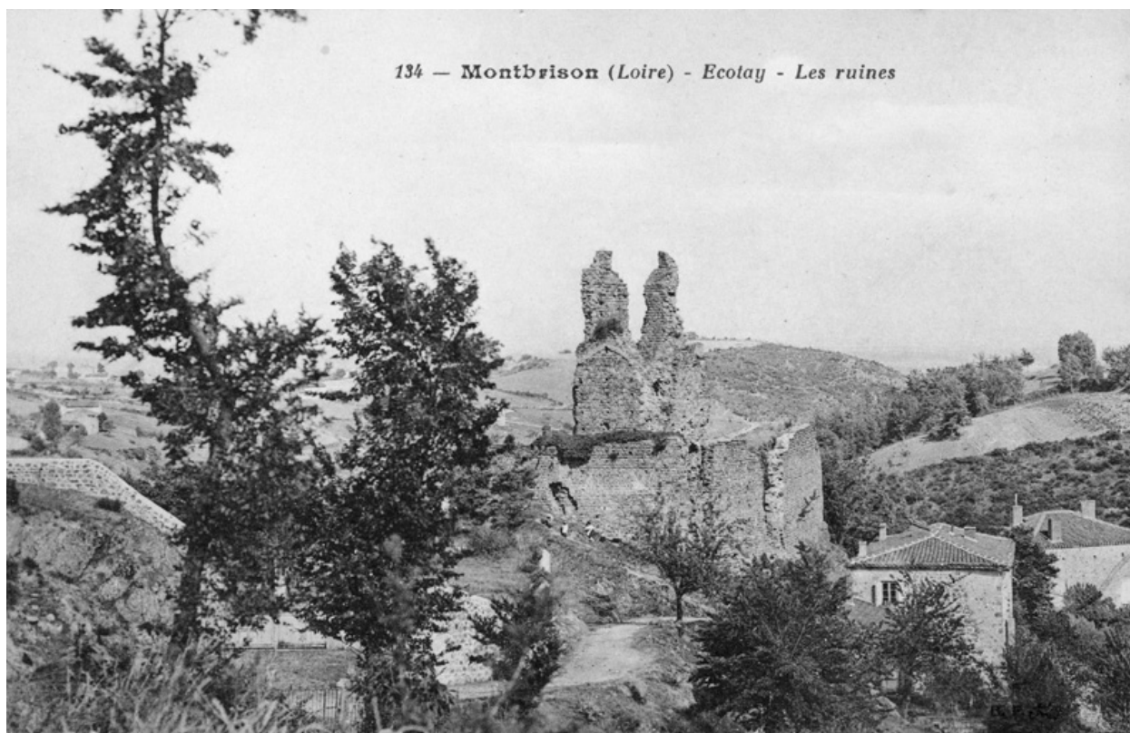
134 - MONTBRISON (Loire) - ECOTAY - Les ruines. B. F. [Vue d'ensemble du donjon depuis l'ouest].
