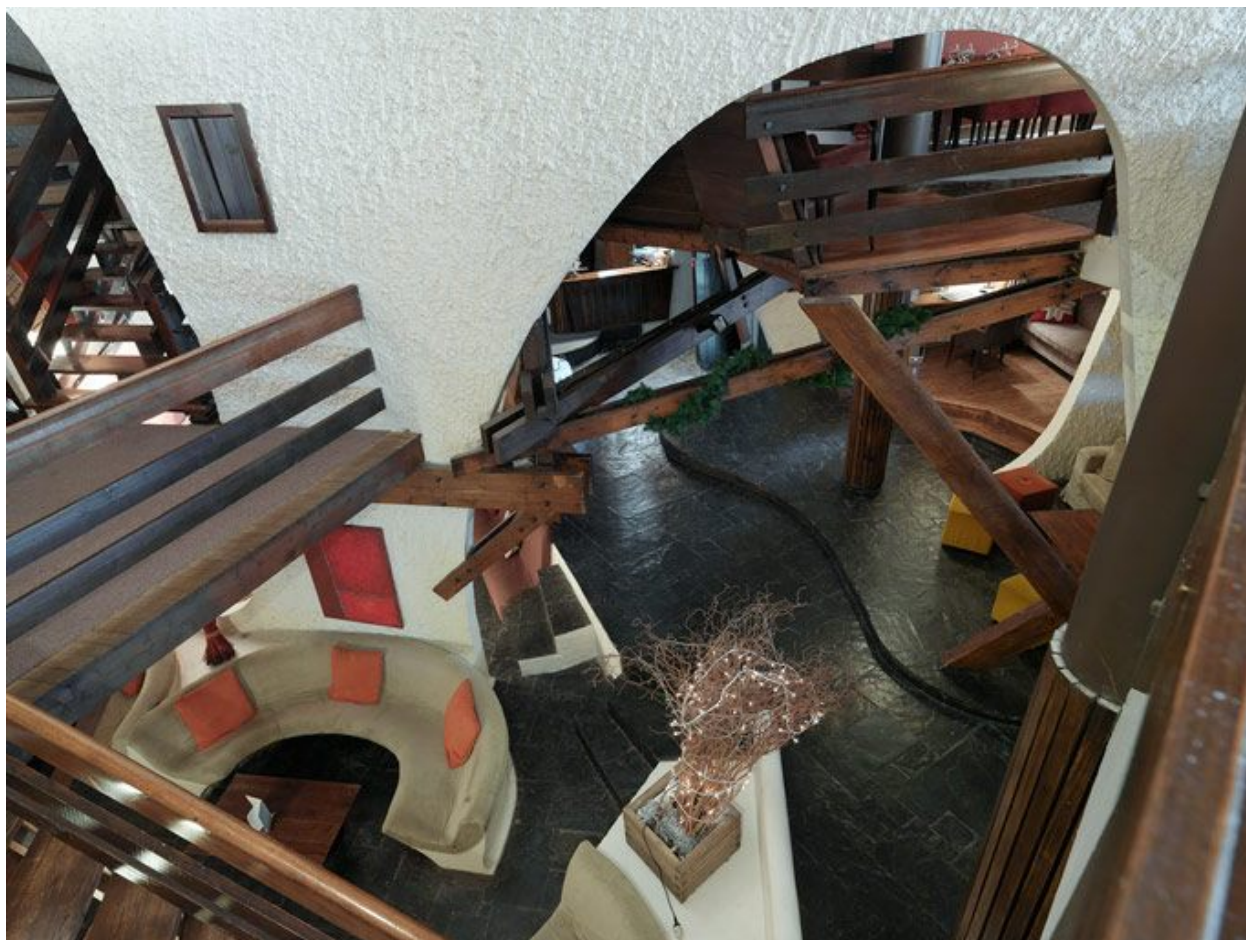
Assemblage de charpente soutenant les passerelles au-dessus des coins salon et feu
