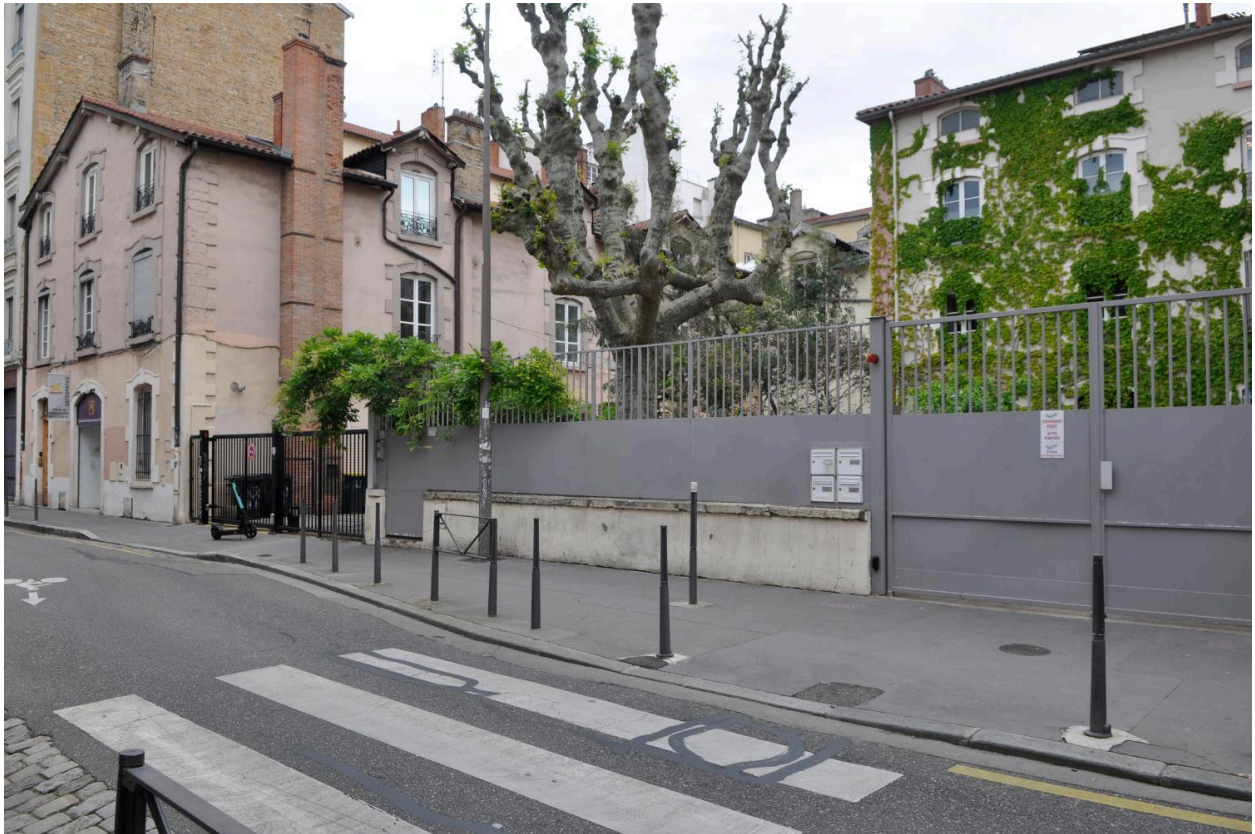
Vue des bâtiments subsistants, depuis la rue Pasteur (aile nord et bâtiment de la meunerie)
