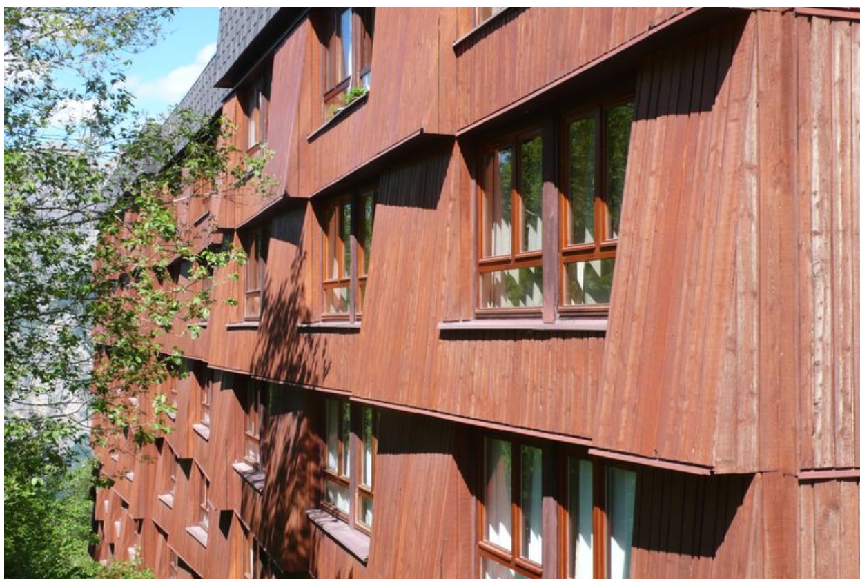
Détail de la structure de la façade
