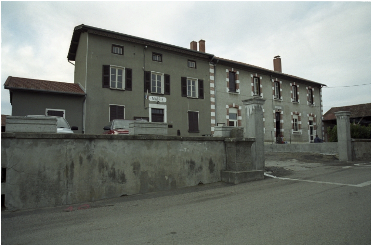
Vue d'ensemble de l'école construite en 1909, et de la mairie.
