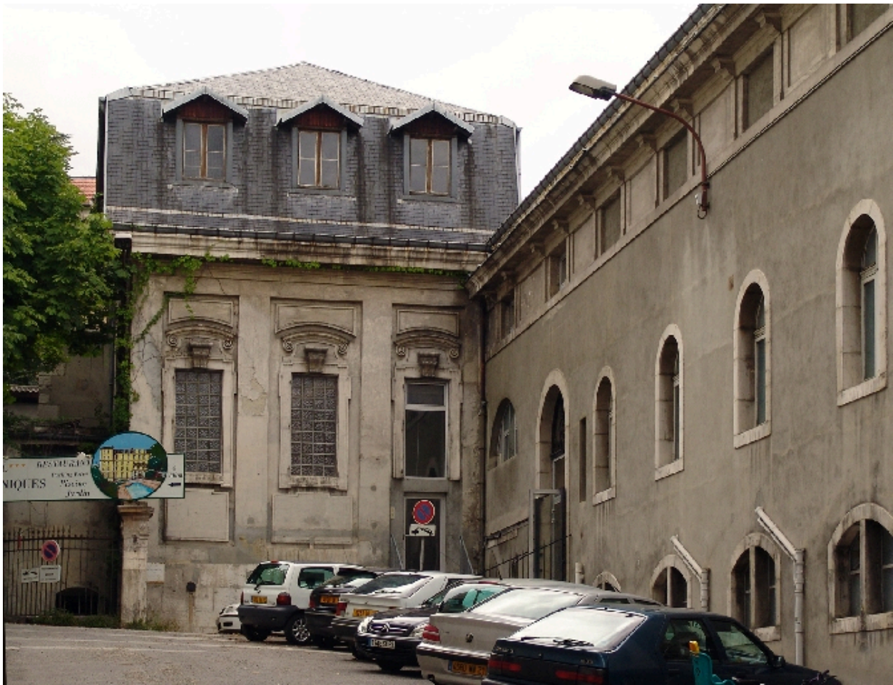
Façade, aile gauche
