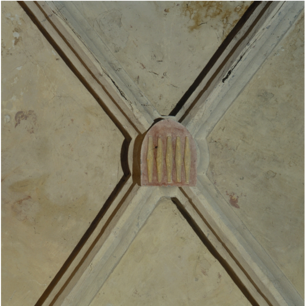
Clef de voûte aux armes des Saint-Nectaire, troisième travée du bas-côté (f).
