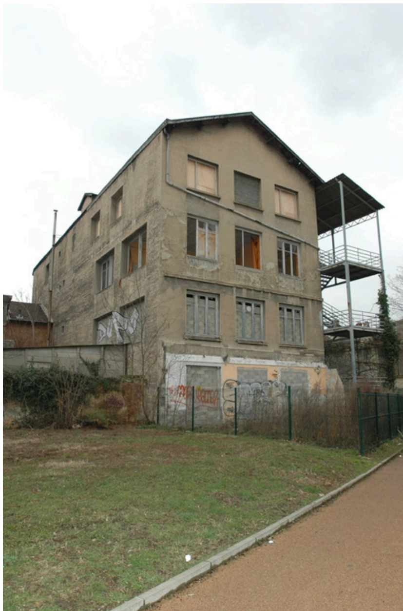
façade arrière de l'usine, vue nord.
