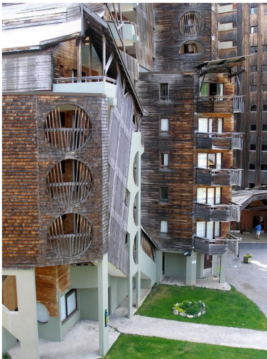
Façade nord depuis le sud-est
