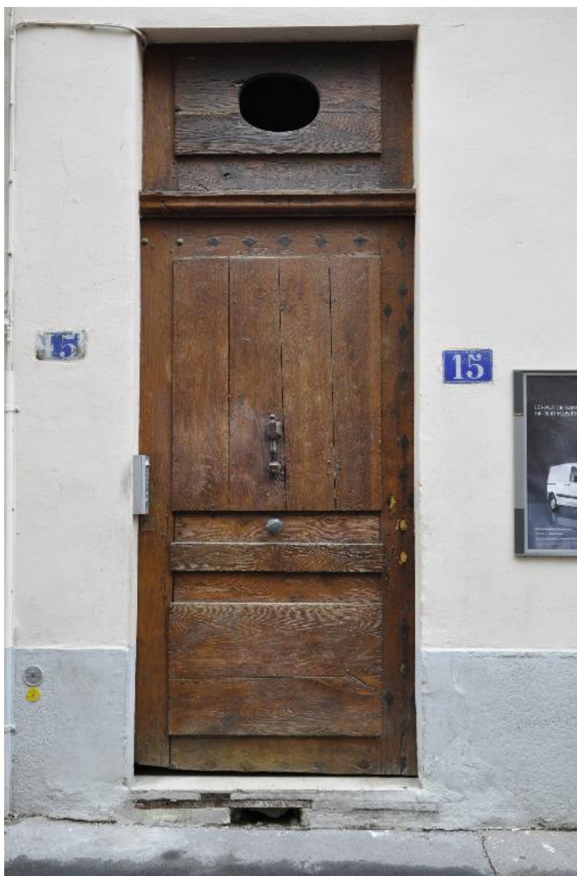
Porte de l'immeuble n°15 rue Dumenge
