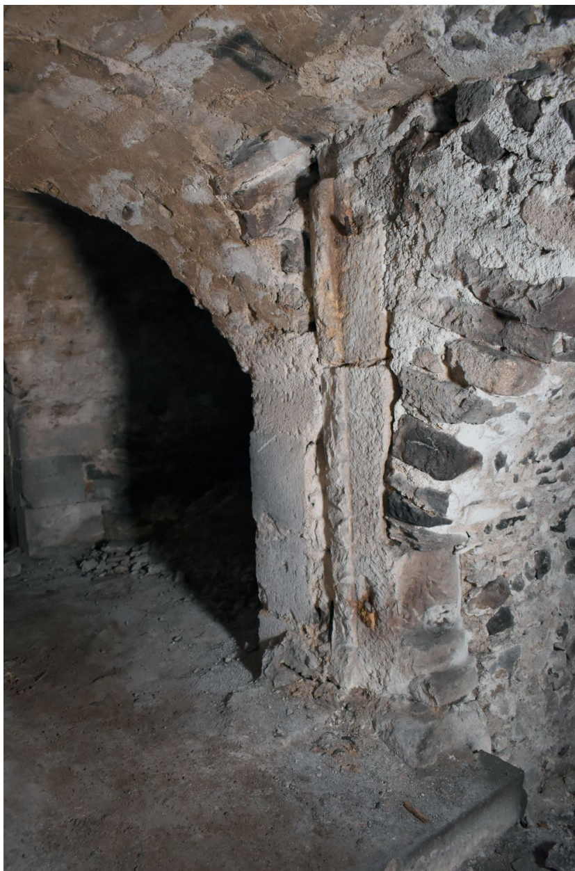
Caves nord, salle n°11 : détail de l'ancien encadrement de porte, passage vers la salle n°10
