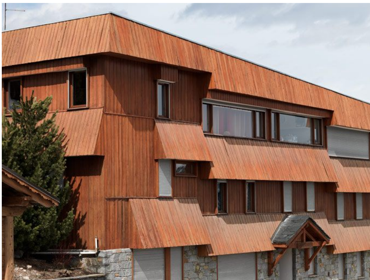
Résidence le Grand Charriot, angle sud-est
