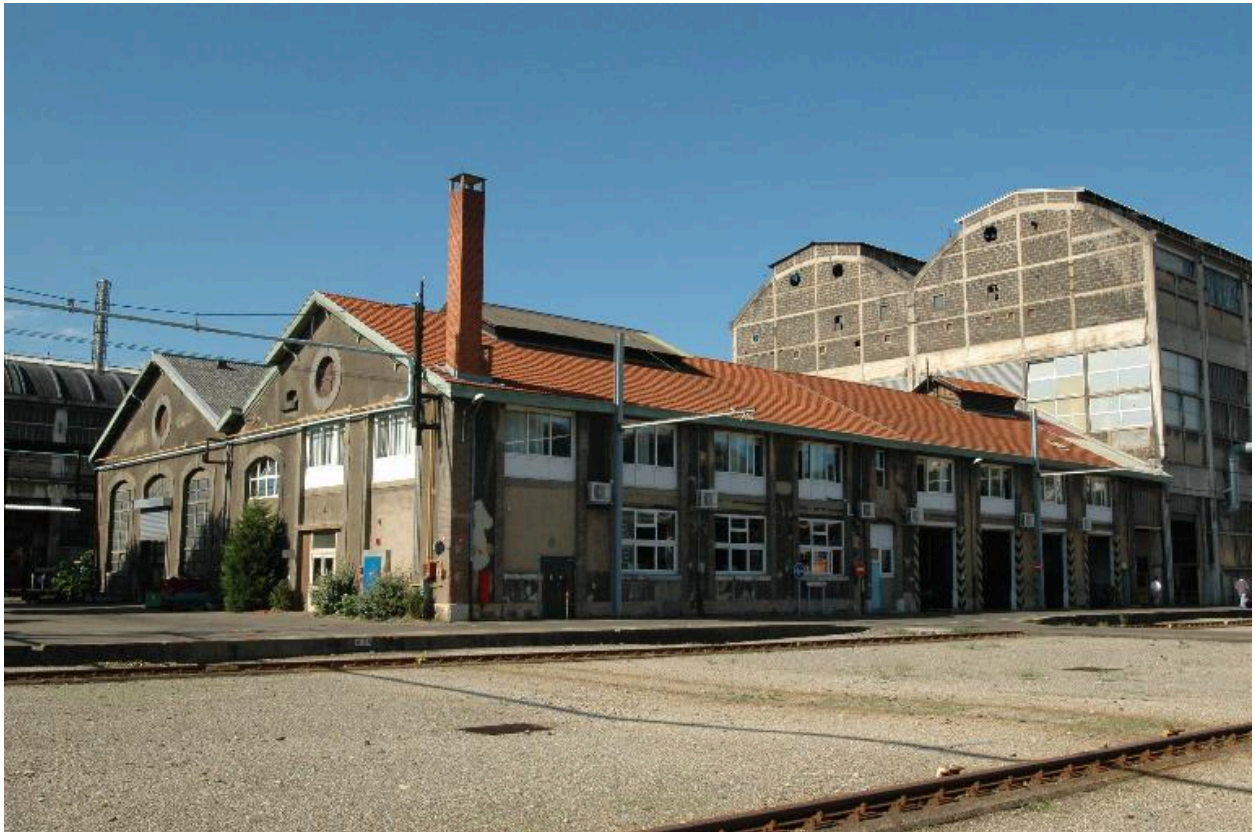
Vue extérieure de ateliers de 1860.
