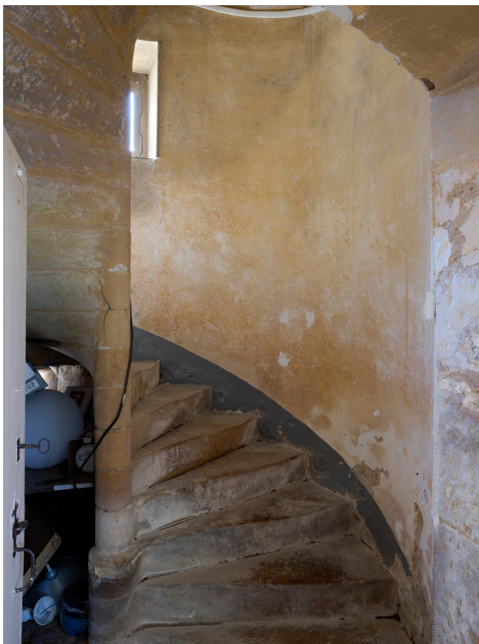
Escalier en vis à marches portant noyaux de la tourelle de l'ancien logis.
