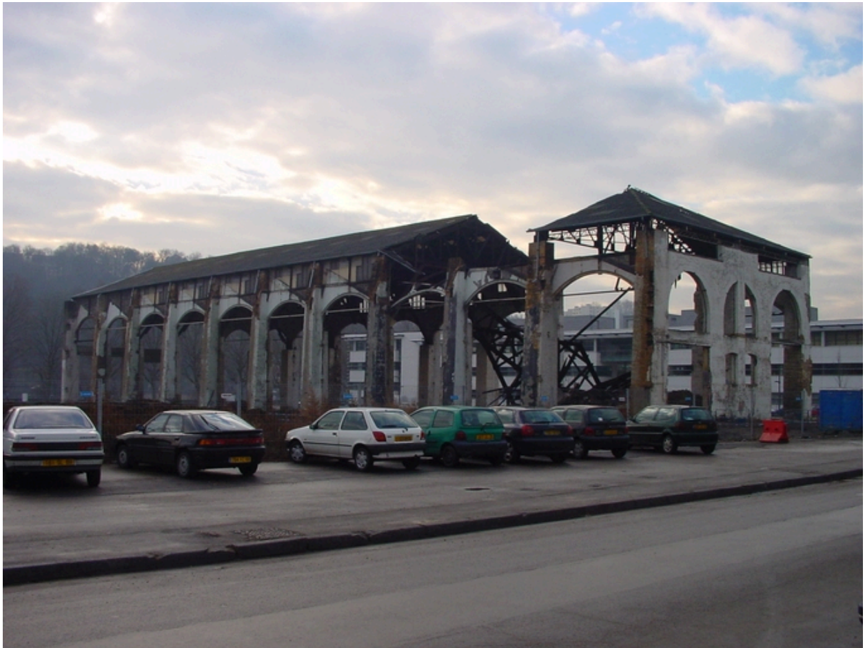
Vue d'ensemble de la halle après destabilisation
