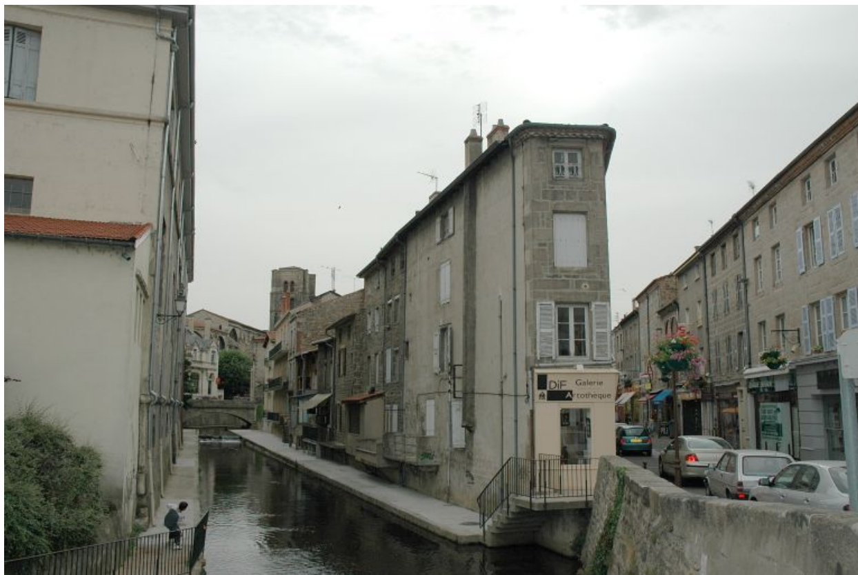
Vue d'ensemble du côté du Vizézy.
