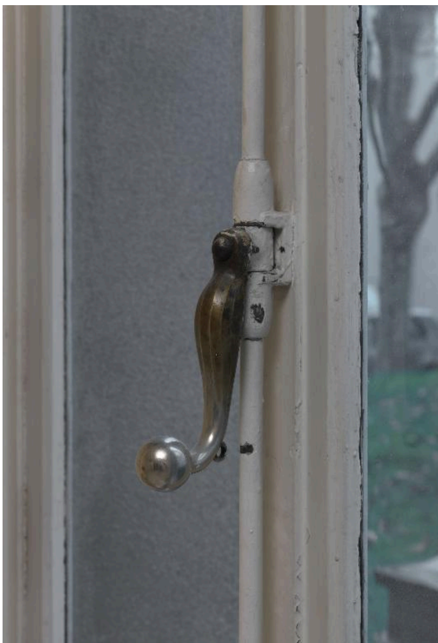
Le pavillon H en 2014 : rez-de-chaussée, crémone d'une fenêtre en bois
