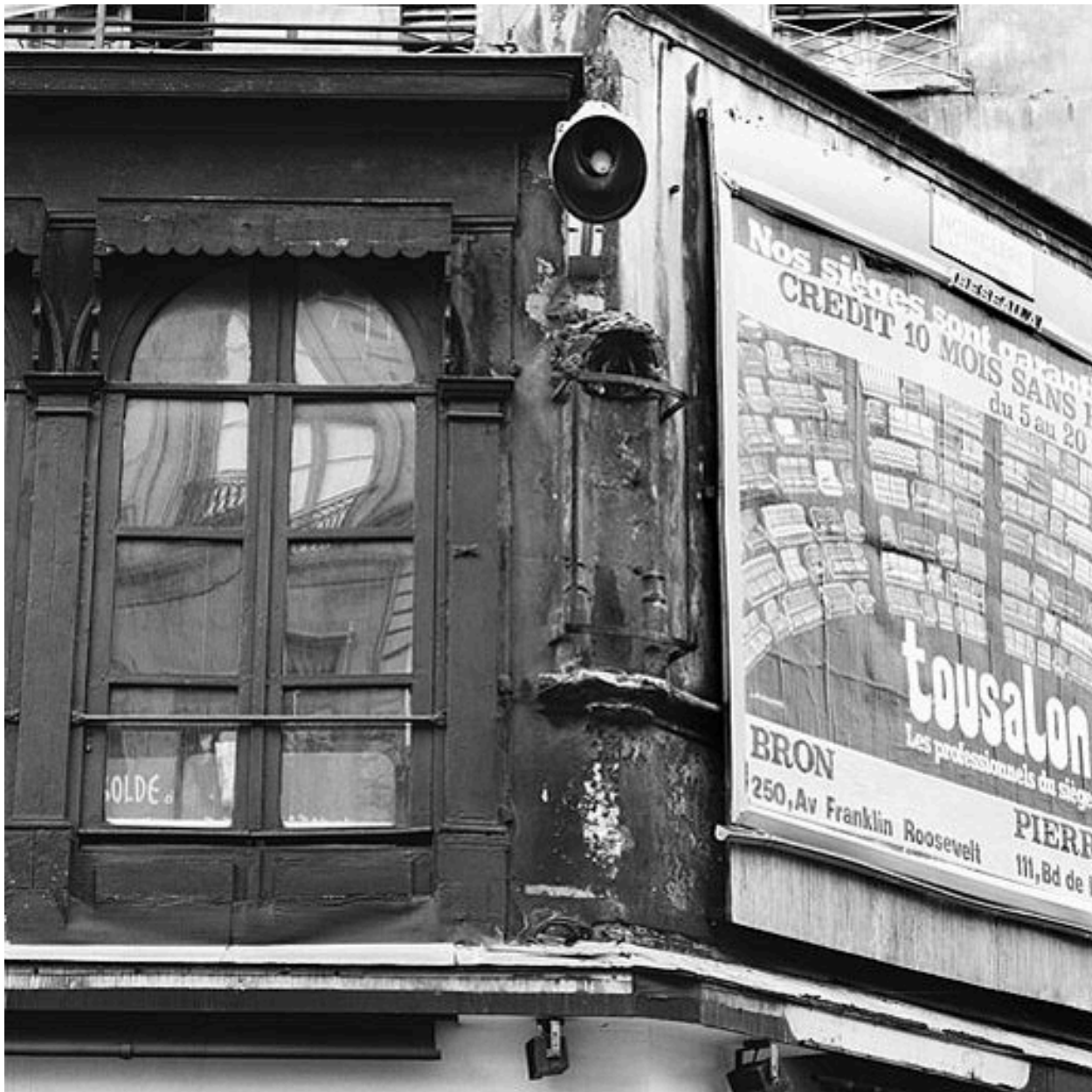
Niche gothique située à l'angle de l'immeuble
