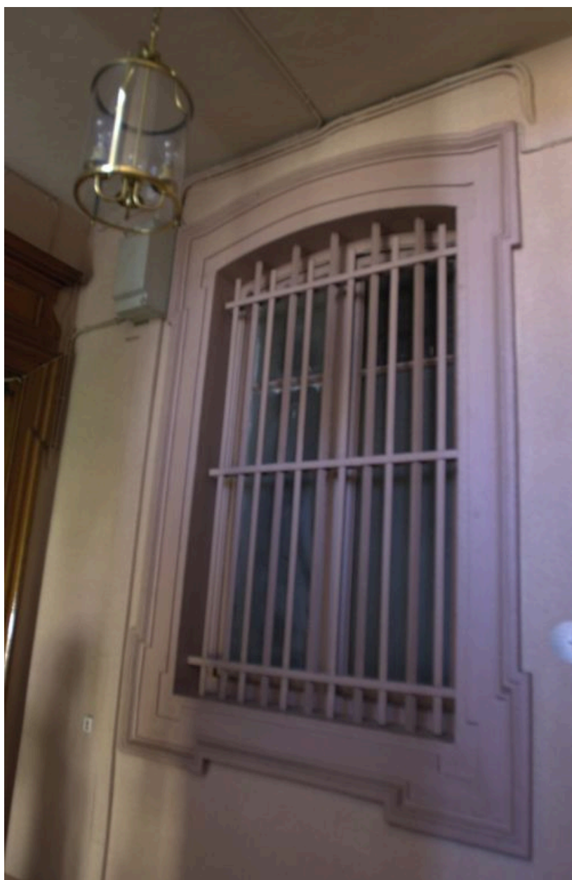
Détail d'une fenêtre (cuisine) ouvrant sur la cage d'escalier
