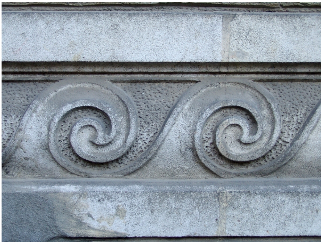
Frise sur façades
