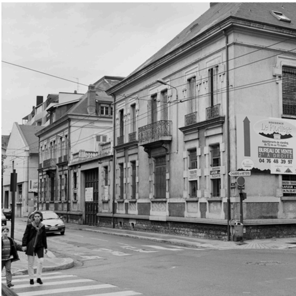
Vue des 2 pavillons conservés
