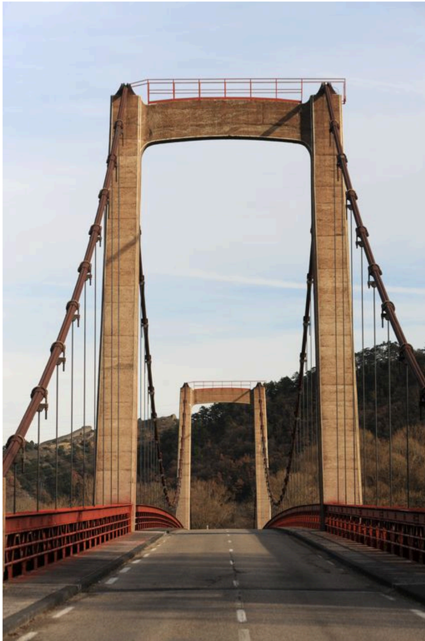
Vue partielle, de dessus, chaussée et piles (depuis la rive droite)
