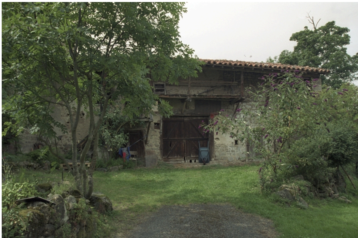
Saint-Laurent-Rochefort, Chazelles-bas (1987 C3 767, 967), type A1. Façade antérieure de la grange-étable.
