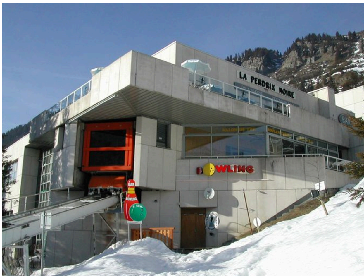
Vue depuis le sud-est et la gare supérieure de l'ascenseur 2
