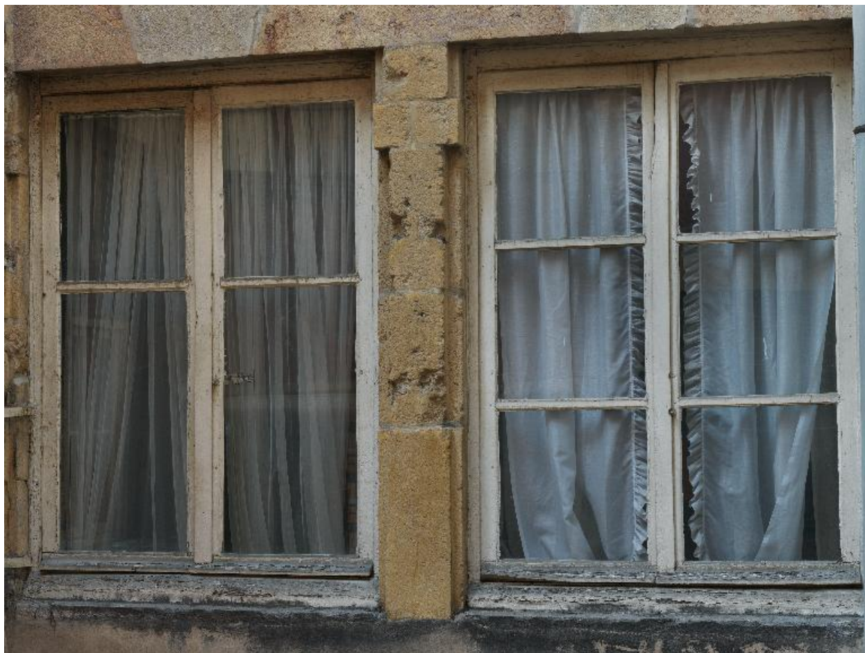
Corps de bâtiment sur cour : baies jumelées
