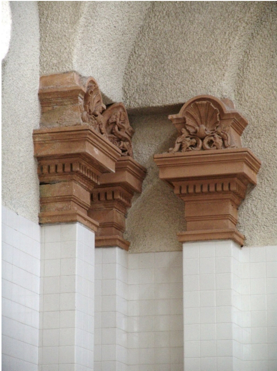
Détail des châpiteaux de la piscine des femmes
