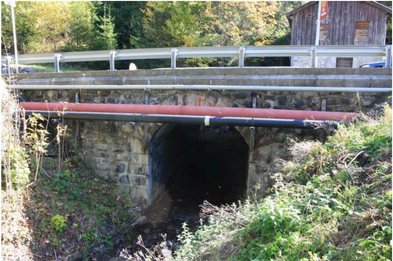
Pont du petit Nant, face aval
