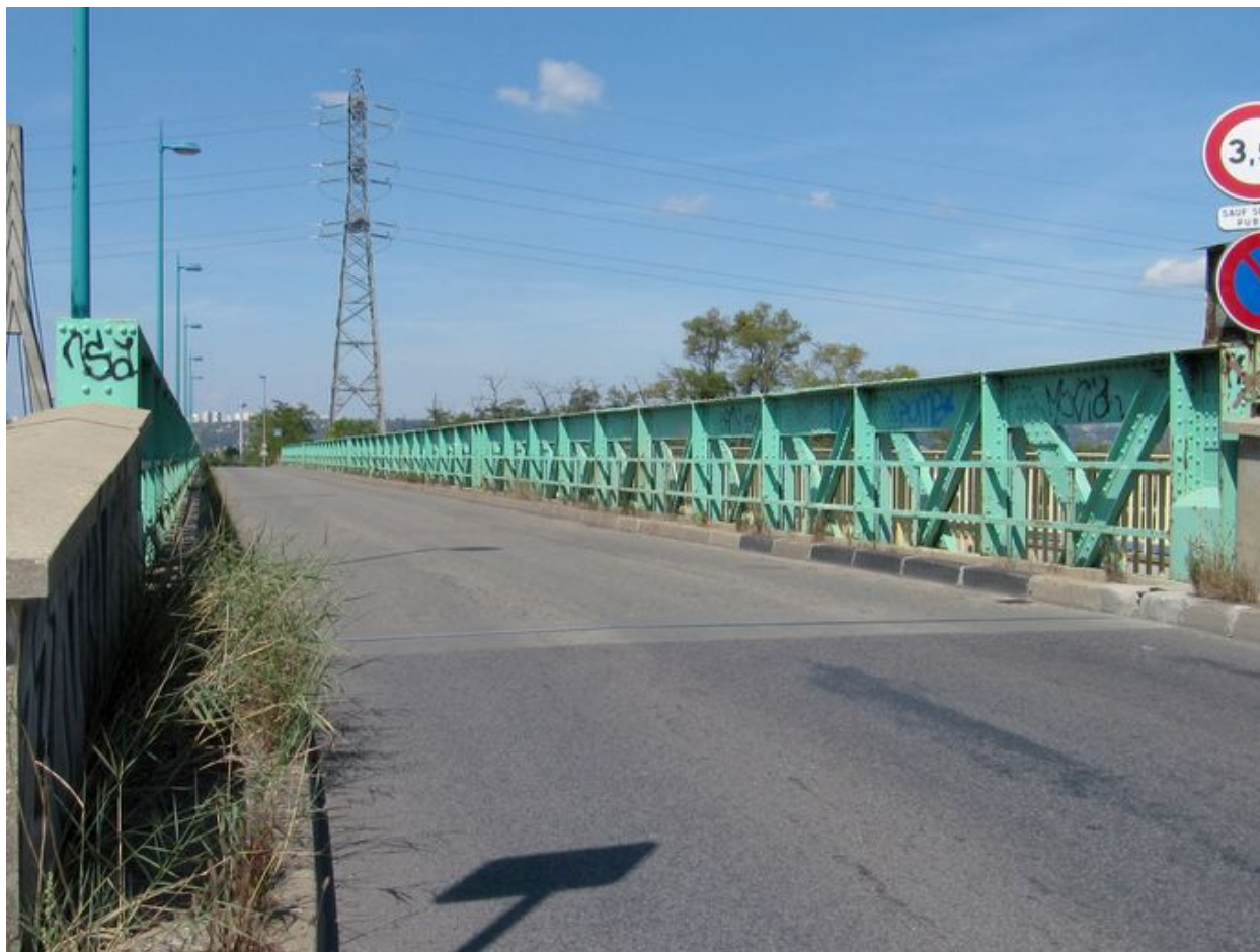
Vue générale, de dessus, chaussée centrale (depuis la rive gauche)
