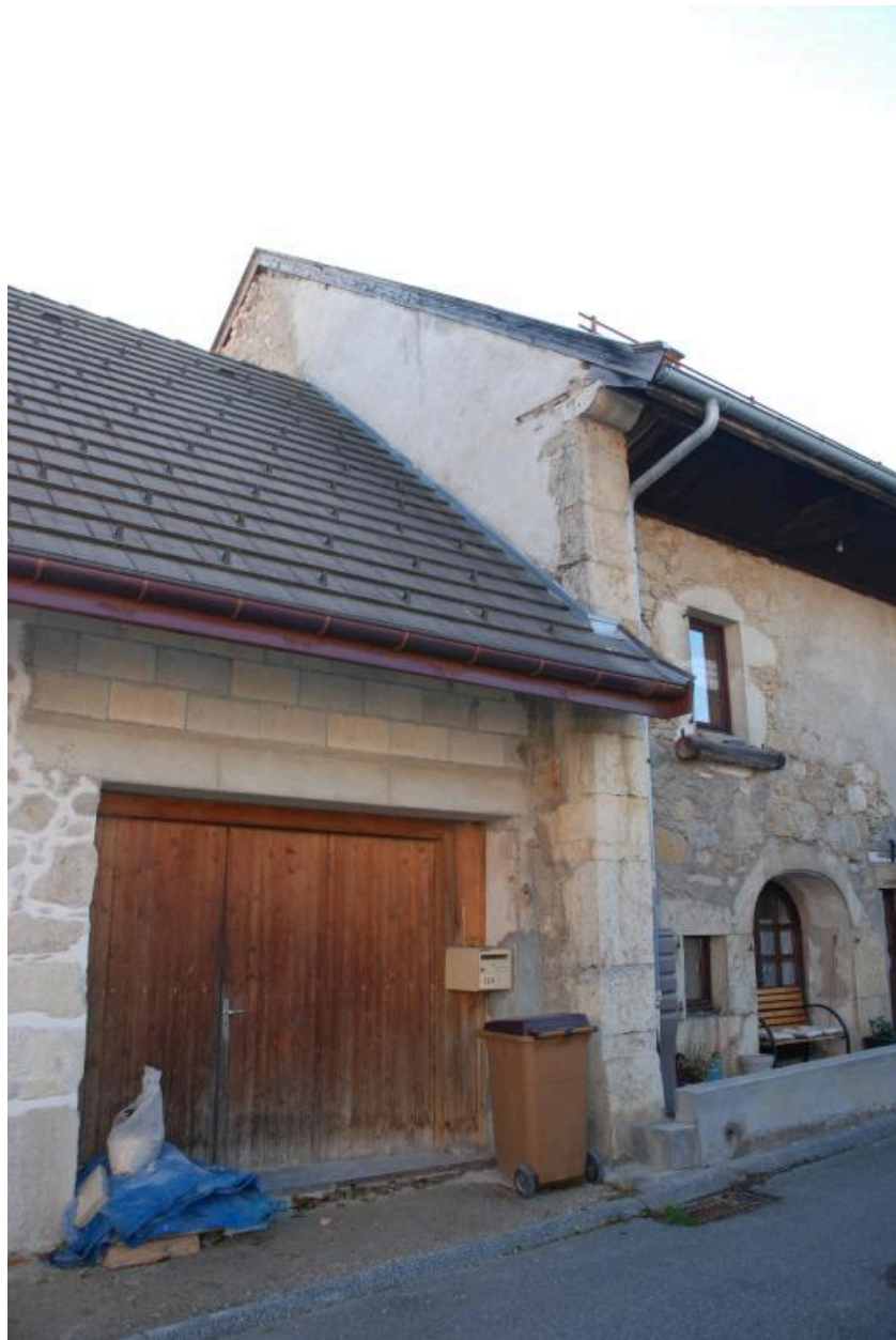
Mur pignon débordant, vue depuis le nord-est.
