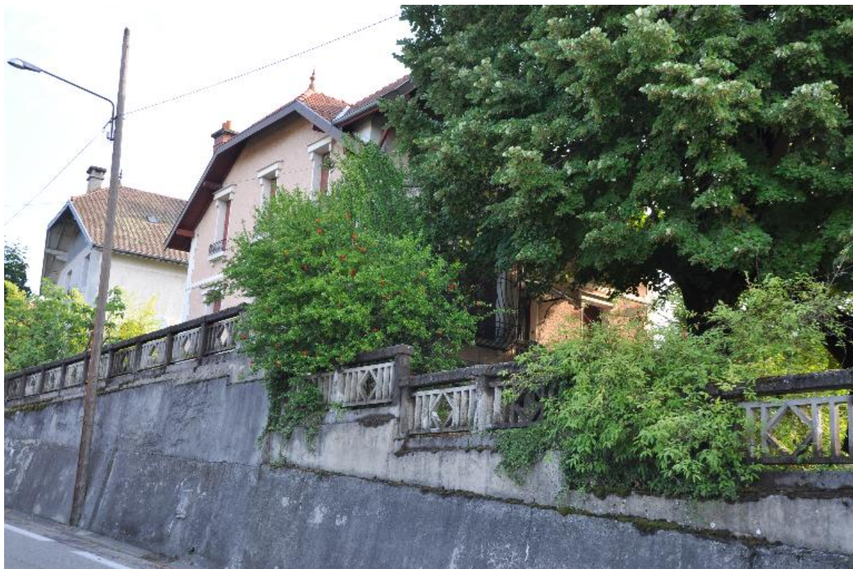
Mur de clôture
