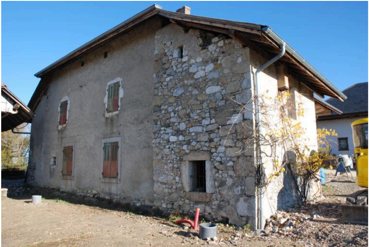
Habitation, vue depuis le sud.
