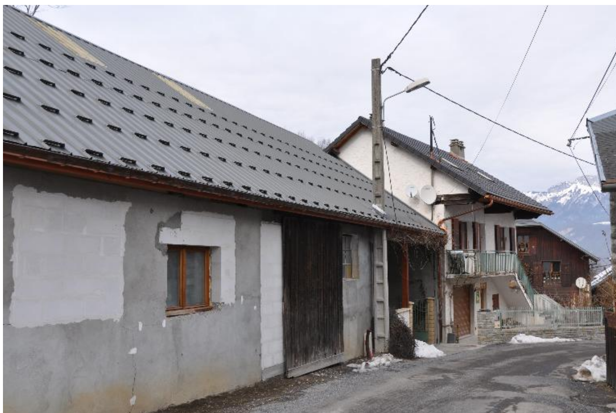
Détail des baies comblées du bâtiment de la remise en 2012
