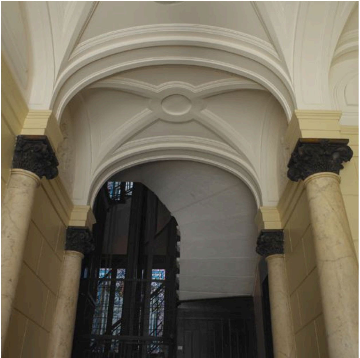
Voûte du vestibule
