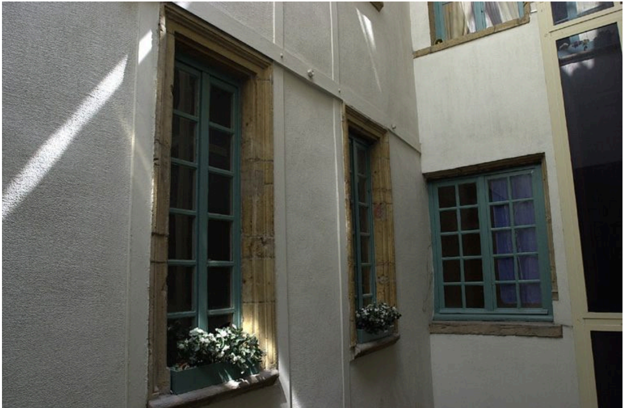
Corps de bâtiment nord sur cour : détail de baies
