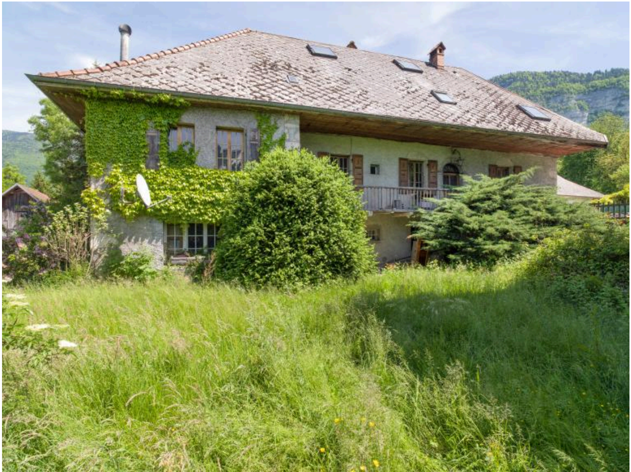
Vue d'ensemble de la façade latérale gauche.
