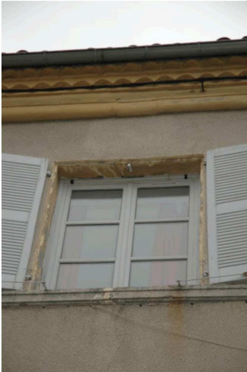
Fenêtre du 2e étage. Au-dessus, corniche en pierre doublée d'une génoise.
