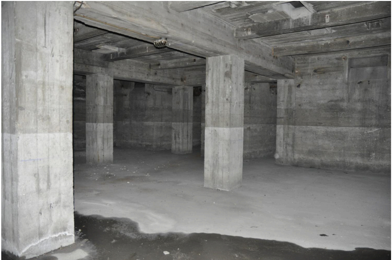
Vue du sous-sol
