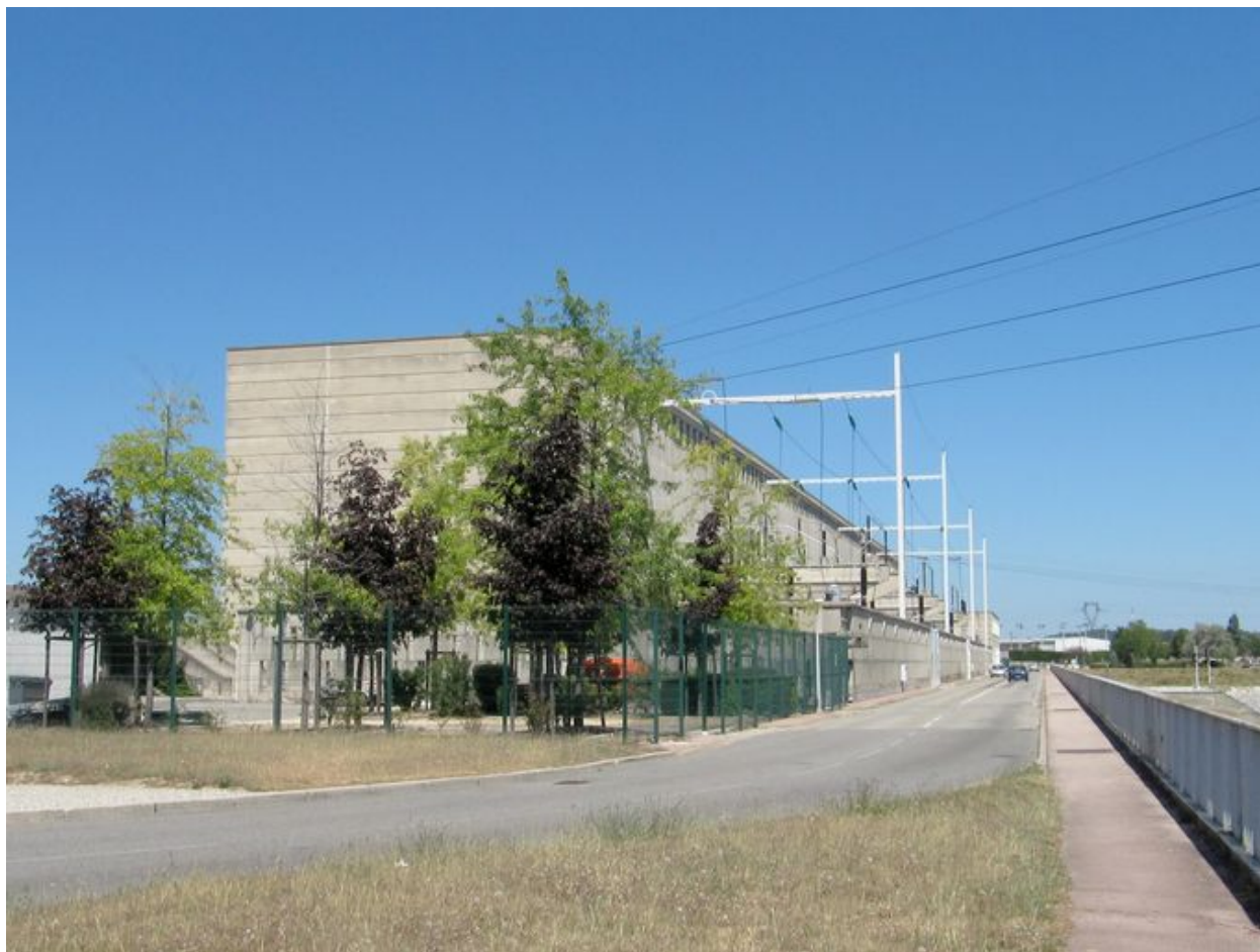
Vue générale depuis la rive droite ; chaussée du pont routier
