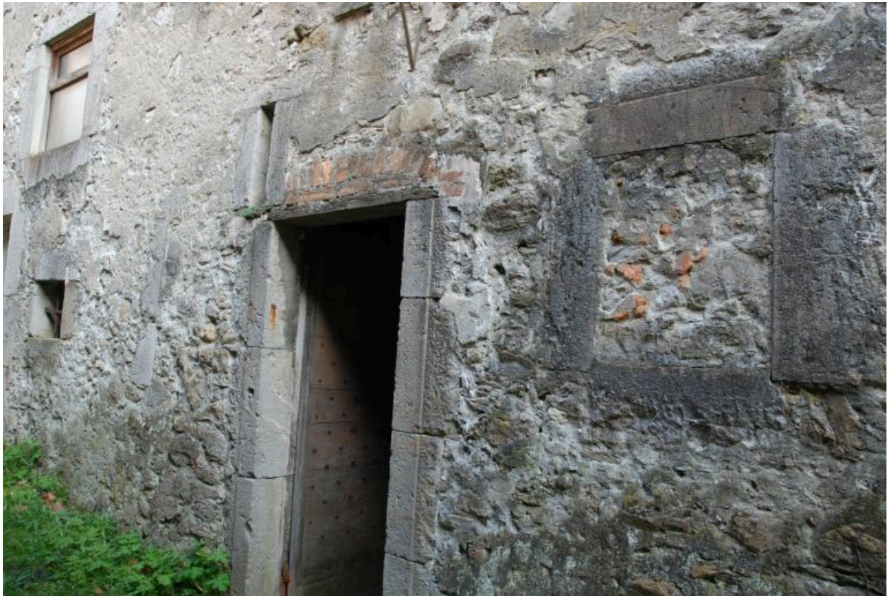
Pignon nord de la demeure, détail de la porte d'accès à l'ancienne cuisine du fermier (Cf. Plan RDC 3).
