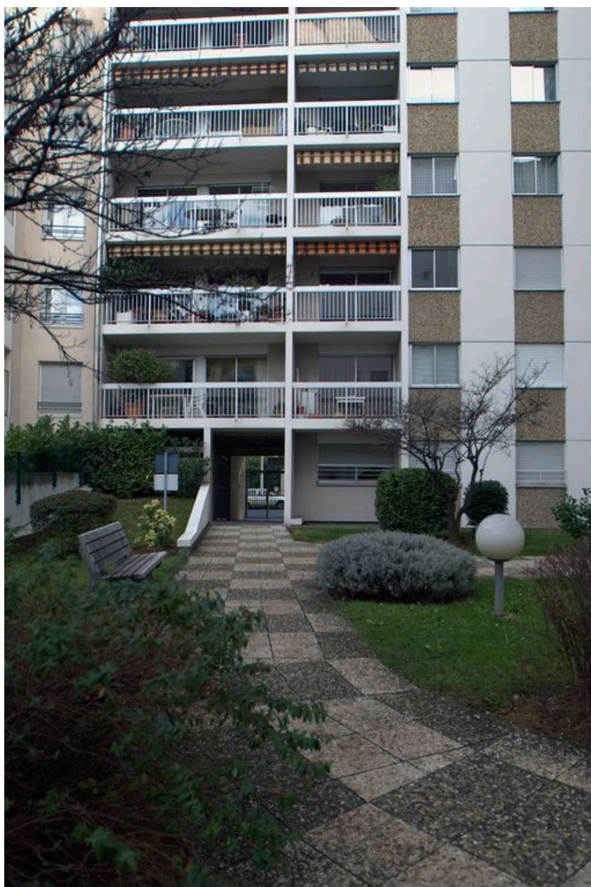
Elévation postérieure du corps de bâtiment nord
