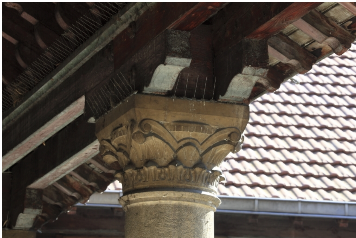
Cour G. Détail d'un chapiteau.
