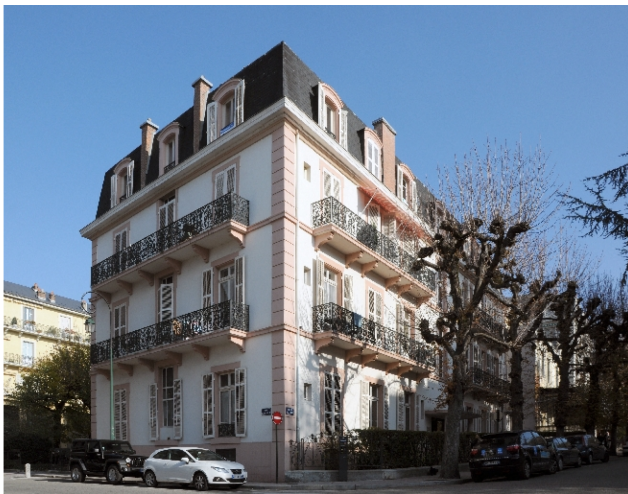
Vue de trois-quart depuis le sud-ouest
