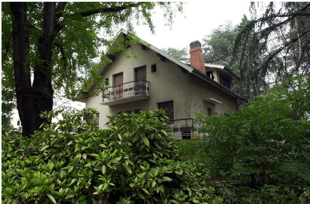
Elévation sud-ouest : détail de la partie haute
