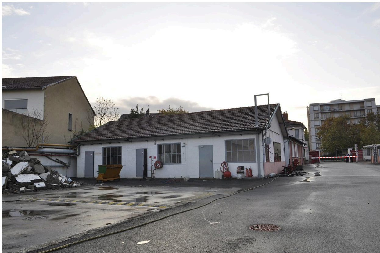
Site au moment de la démolition de la partie Givaudan-France en 2011
