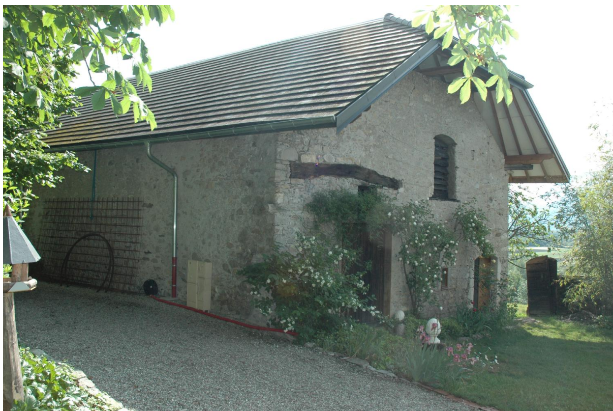
Vue de la grange.
