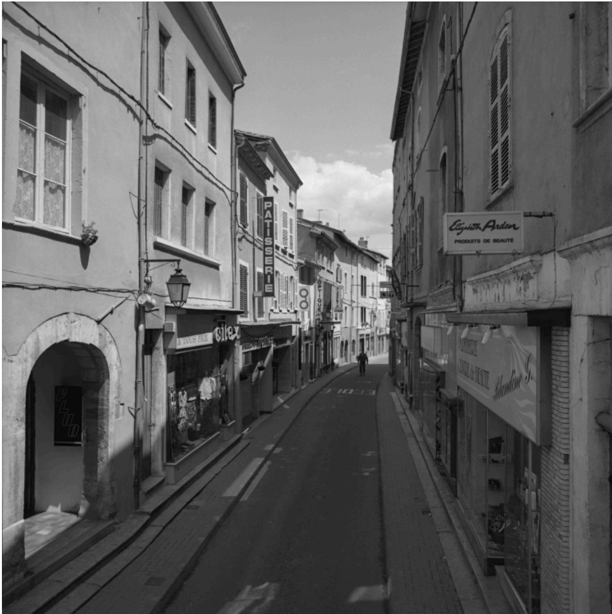
Vue de l'élévation principale (pâtisserie) dans l'alignement de la rue.
